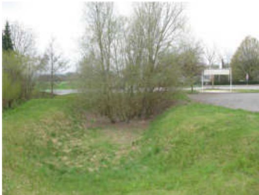
Abb. 32 Regenrückhaltebecken im Südosten des Plangebietes.
