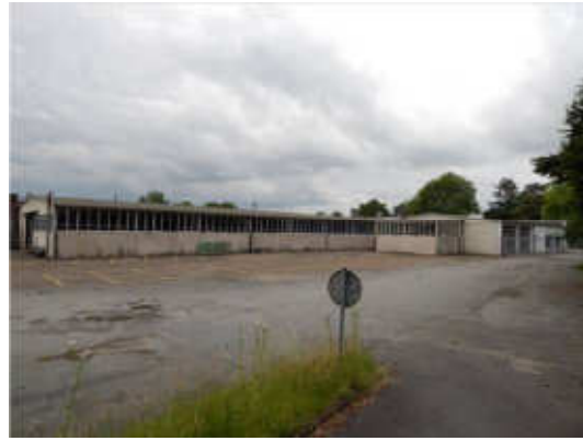
Abb. 4 Blick von Nordwesten auf das ehemals als Autohaus genutzte Gebäude. Im Vordergrund die ehemaligen Stellplatzflächen.
