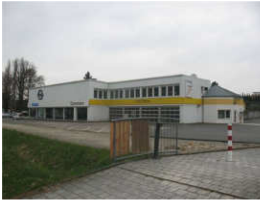
Abb. 3 Blick von Süden auf das ehemals als Autohaus genutzte Gebäude.
