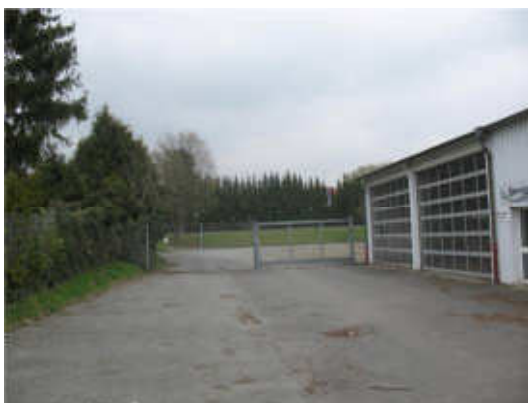
Abb. 7 Westliche Zufahrt und Zaunanlage.
